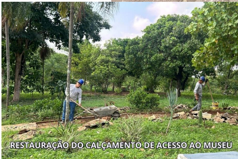
Recebimento e colocação dos bloquetes
